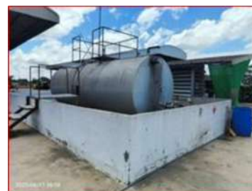
กำแพงกันรั่วกักเก็บน้ำมันโซล่า (Bound Wall)
