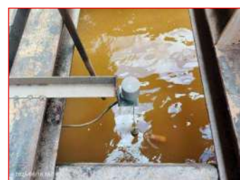
การติดตั้ง Level switch
