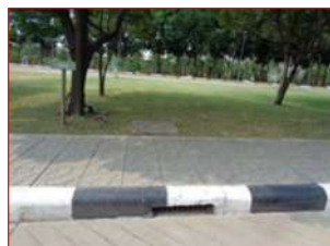
รางระบายน้ำฝนที่ไม่ปนเปื้อน
